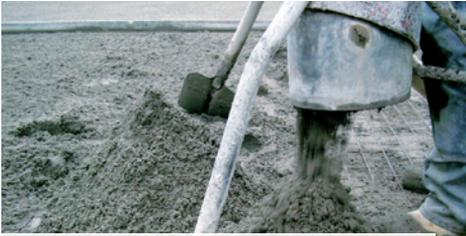
**1** Einbau eines Zementestrichs als Industriestrich
