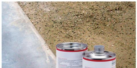
**6** Tagesansatzfugen sollten vor der Bodenbelagsverlegung mit einem Reaktionsharzsystem »kraftschlüssig« verschlossen werden
