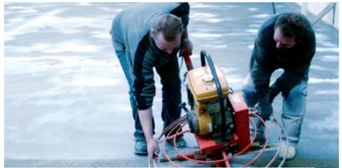
**4** Nach dem Einstreuen der Hartstoffe werden diese mittels Glättmaschine in die noch frische Oberfläche eingeglättet
