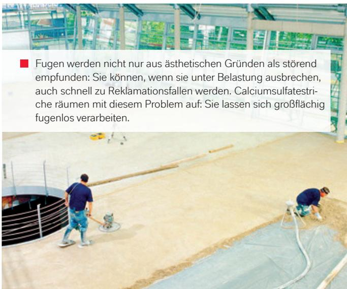
■ Fugen werden nicht nur aus ästhetischen Gründen als störend empfunden: Sie können, wenn sie unter Belastung ausbrechen, auch schnell zu Reklamationsfällen werden. Calciumsulfatestriche räumen mit diesem Problem auf: Sie lassen sich großflächig fugenlos verarbeiten.
