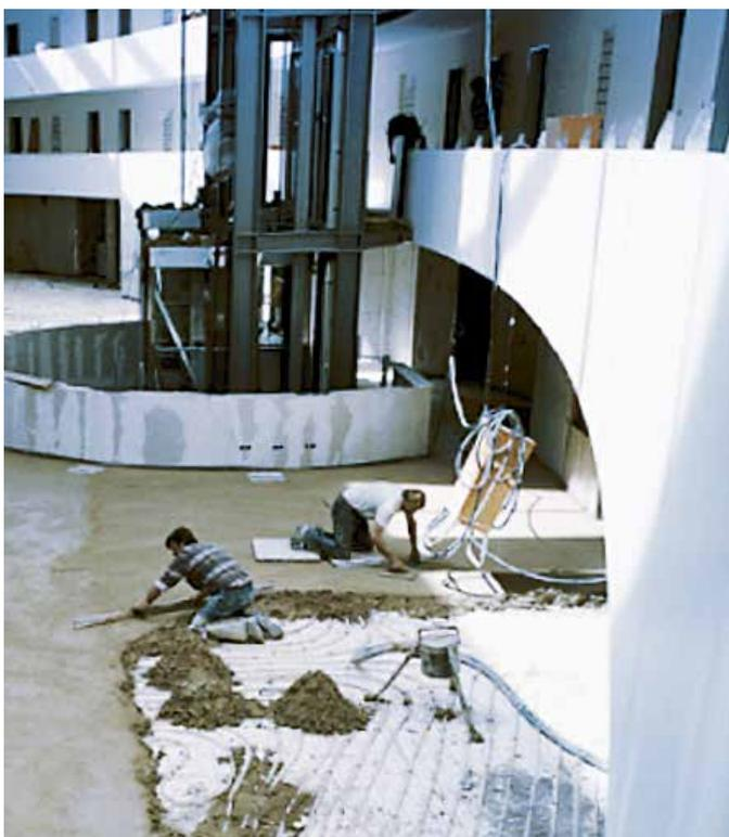
**Fußbodenheizungen können bereits nach sieben Tagen in Betrieb genommen werden - bei Zementestrichen muss drei Wochen gewartet werden. Auf Bewehrungen kann verzichtet werden. Das sind nur zwei Vorteile, die konventioneller Calciumsulfatestrich auf Basis des Calciumsulfatbinders CAB 30 von LANXESS bietet.**
