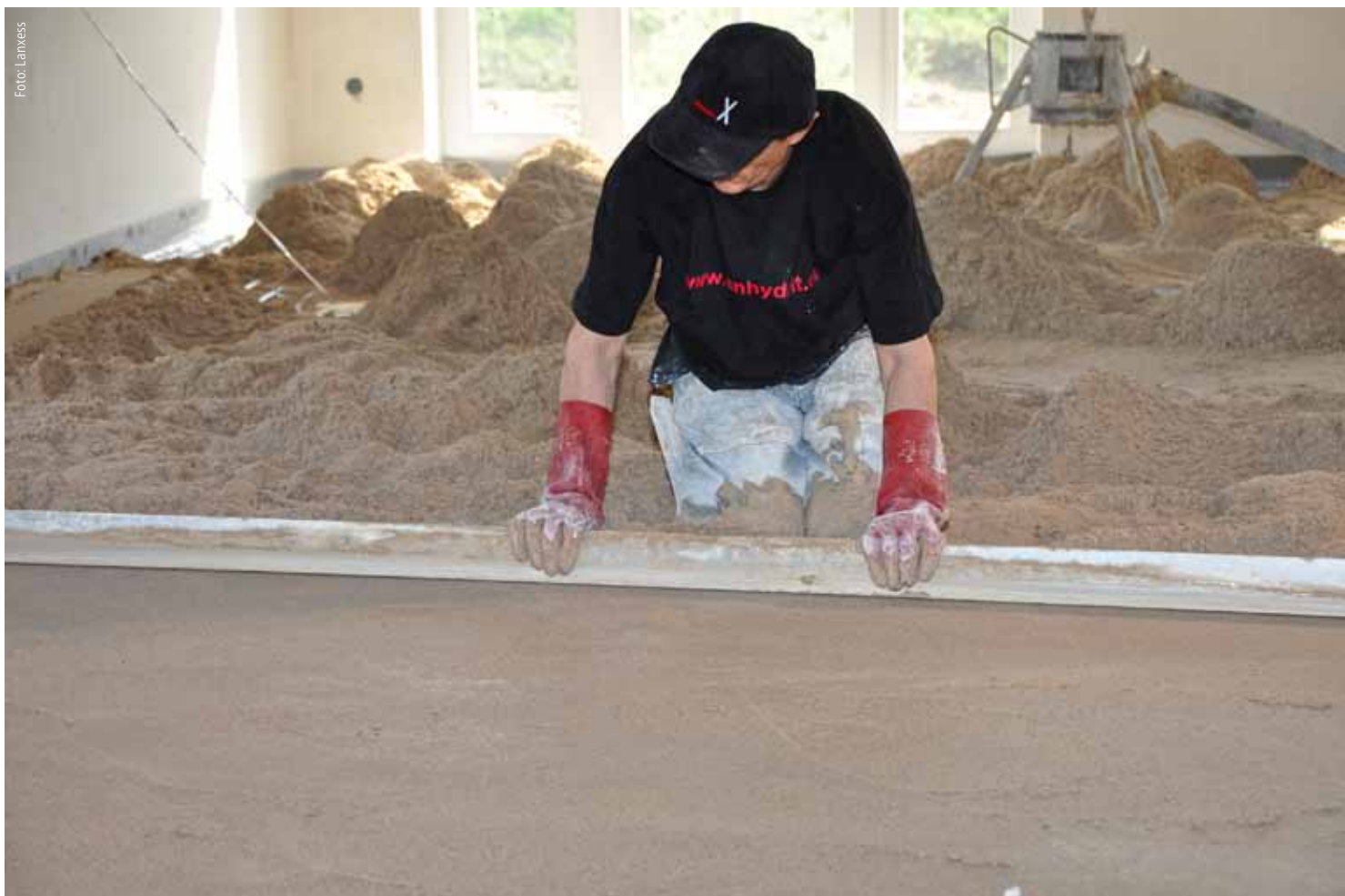
Aufgrund der hohen Raumstabilität können konventionelle Calciumsulfatestriche mit sehr guten Ebenheiten hergestellt werden.
