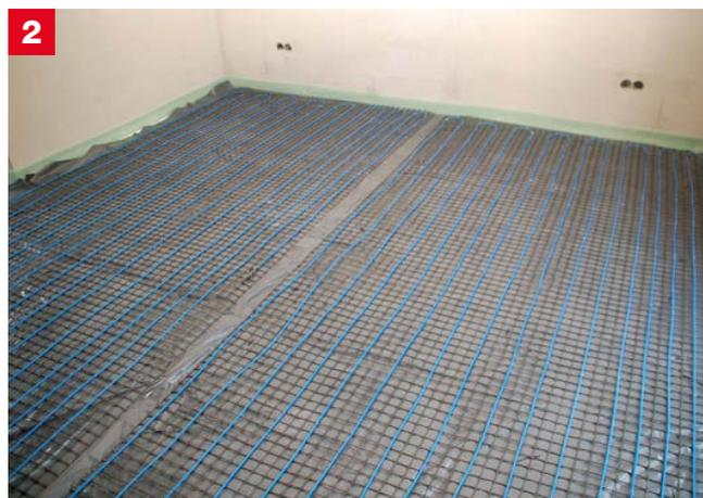
2 Die eingebaute Elektrofußbodenheizung.
