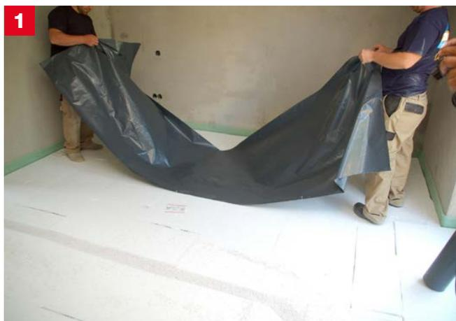
1 Verlegung der Trennschicht auf der zuvor eingebauten Wärmedämmung.
