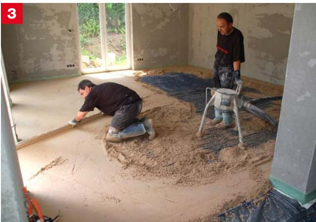
Der Einbau des konventionell hergestellten Calciumsulfatestrichs.
