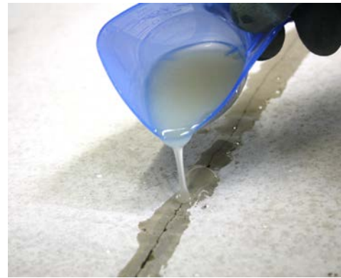
Das Reaktionsharz wurde so lange aufgetragen,
