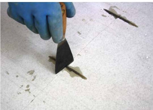
wie bei Variante B eingeschnitten für eine Querverdübelung (Wellverbinder).
