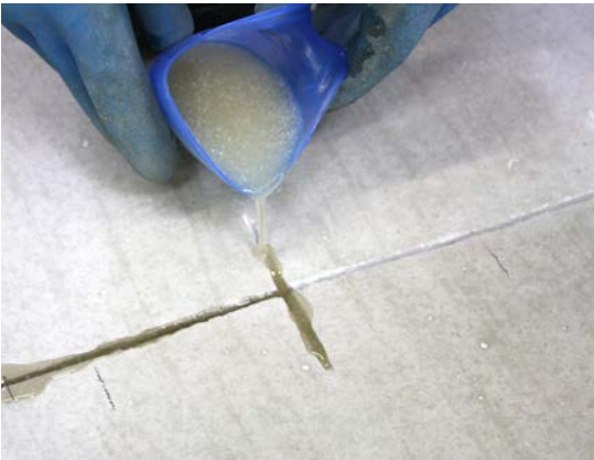
tief aufgeweitet und zusätzlich alle 20 cm quer zum Riss eingeschnitten.
